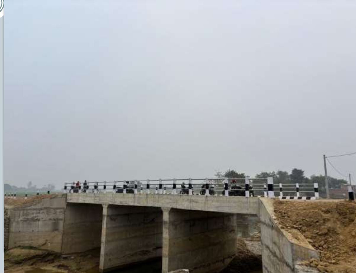
भुताहा खोला मा पुल (३x७ मीटर span)
