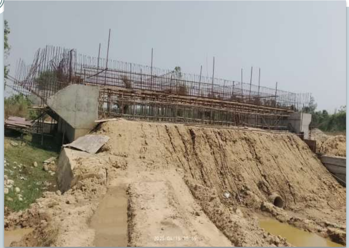
किरण नाला पूल, खजुरा गा. पा. ४ सृजन टोल र जानकी गा. पा. ४ जोडने
