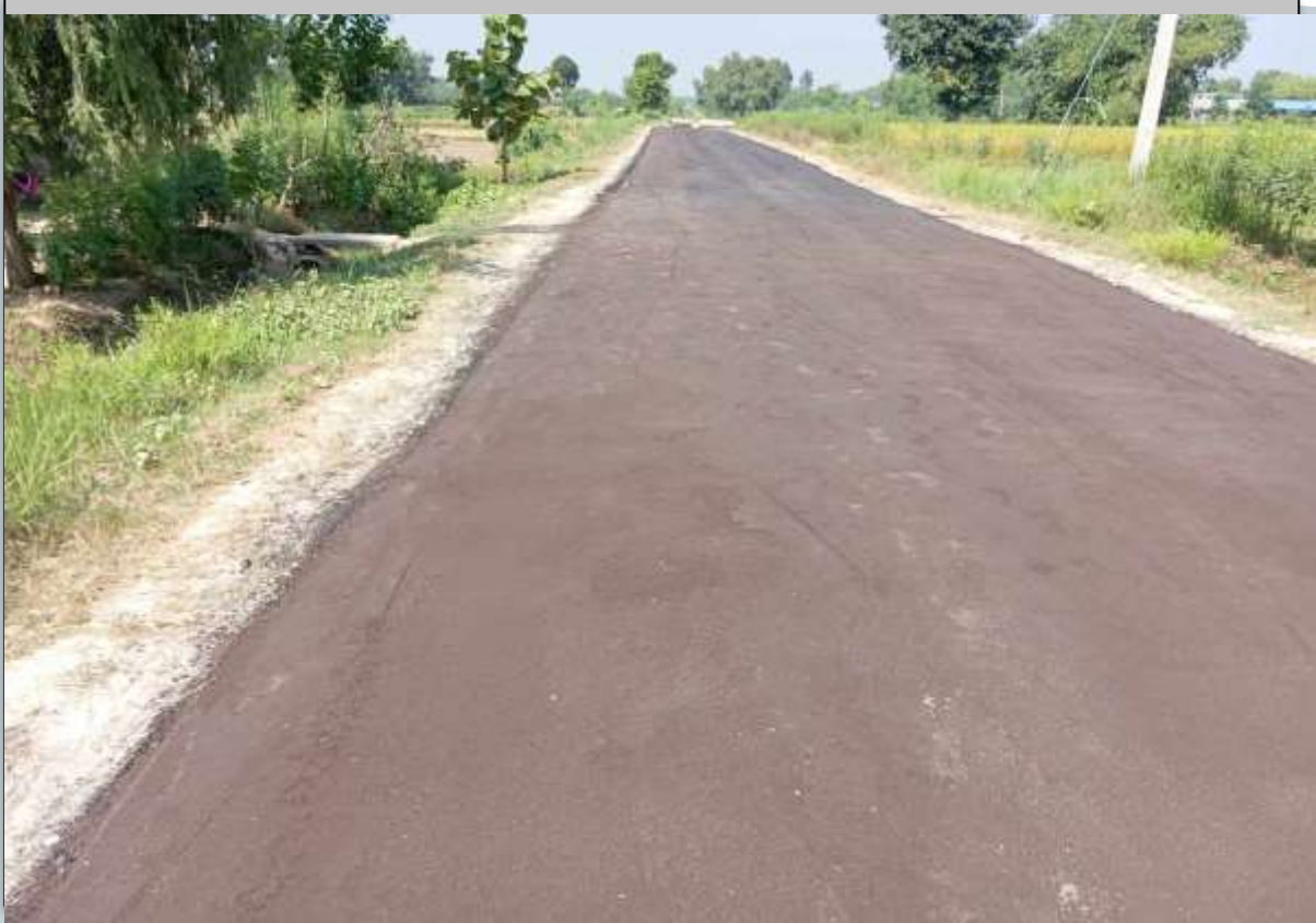
गुलरिया न.पा. १ रावत टोल देखि मधुवन न.पा. ९ गर्भु टोल जोड्ने सडकमा Premix Carpeting को काम ।
