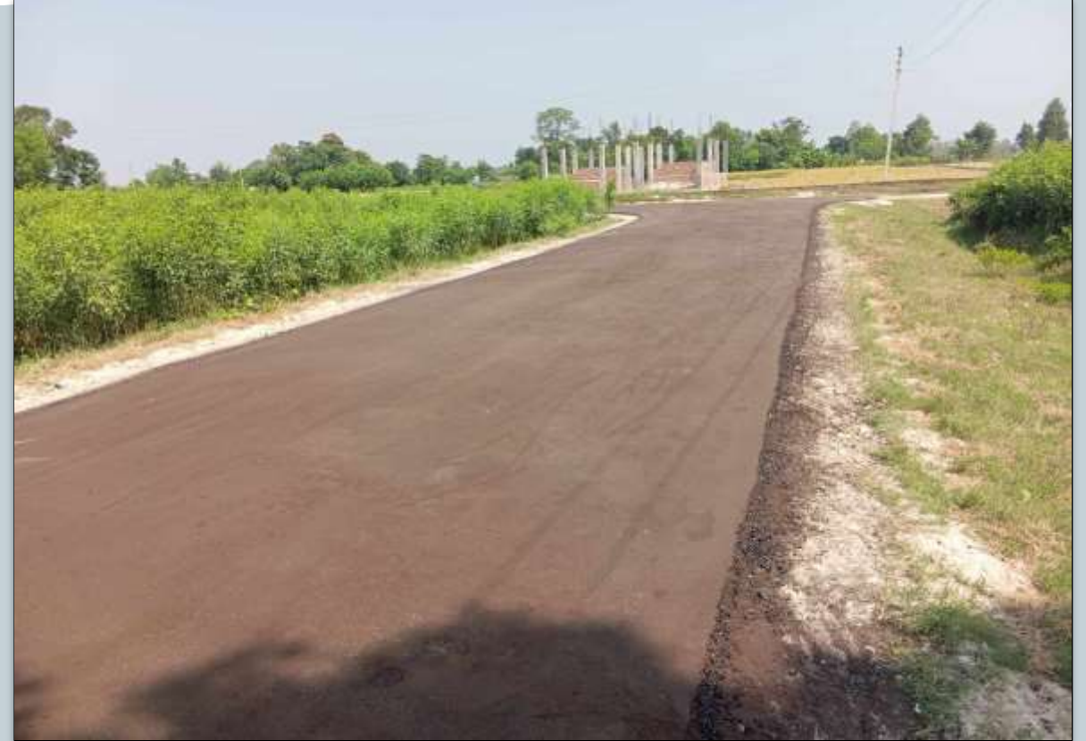
गुलरिया न.पा. १ रावत टोल देखि मधुवन न.पा. ९ गर्भु टोल जोड्ने सडकमा Premix Carpeting को काम ।
