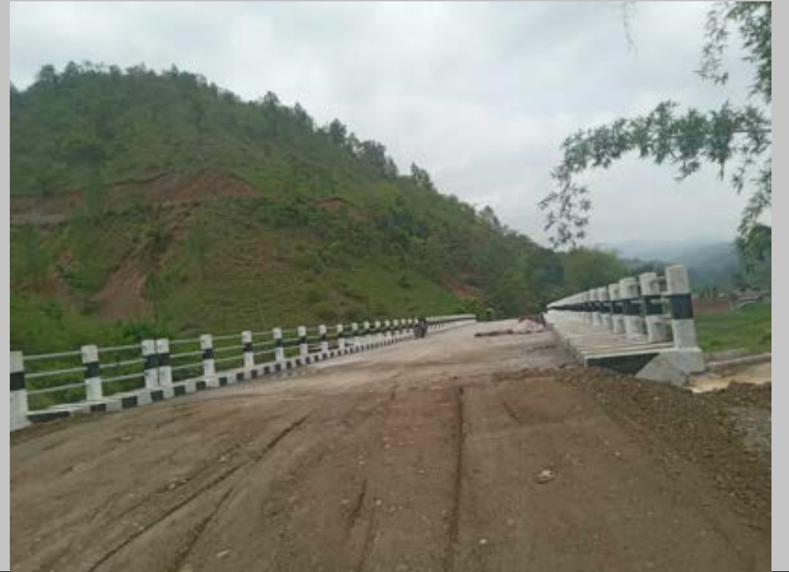
सौर्य खोला सडक पुल, पिपलटारी, अर्घाखाँची
